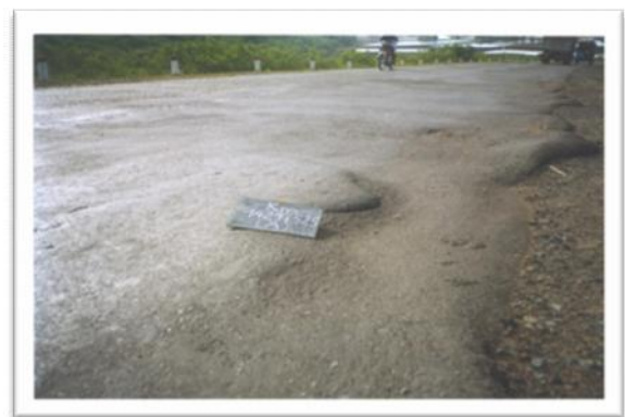
Hình 1. Lắp đặt AC ở R. T. ng, QL IA bị phá
